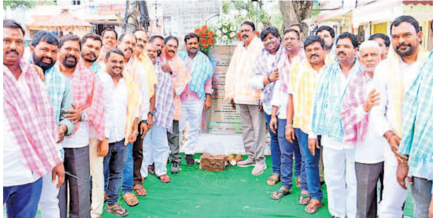
బండ్లగూడలో సీసీ రోడ్డు నిర్మాణ పనులను ప్రారంభిస్తున్న ఎమ్మెల్యే ప్రకాశ్ గౌడ్
