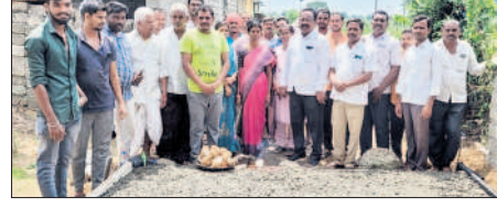
రోడ్డు పనులను ప్రారంభిస్తున్న బజ్జాలి పిచ్చిరెడ్డి
