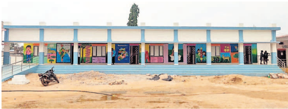
'మన ఊరు-మనబడి' పథకంలో నూతనంగా నిర్మించిన ప్రాథమిక పాఠశాల భవనం
