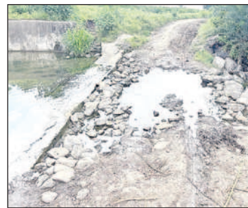
టీవటీ రోడ్డు వద్ద నిర్మాణాల్పన వంతెన
