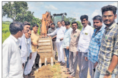
రోడ్డు నిర్మాణ పనులు ప్రారంభిస్తున్న ఎమ్మెల్యే భూపాలిరెడ్డి
