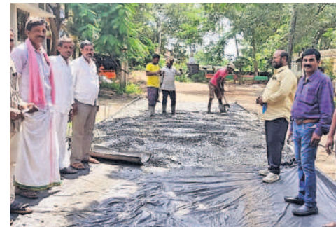
సీసీరోడ్డు నిర్మాణ పనులను ప్రారంభించిన ఎంపీడీవో
