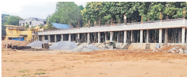
కొనసాగుతున్న జూనియర్ కళాశాల భవన నిర్మాణ పనులు
