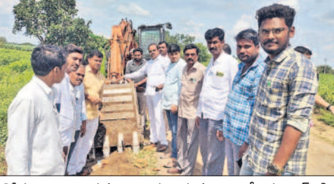
రోడ్డు నిర్మాణం పనులు ప్రారంభిస్తున్న ఎమ్మెల్యే భూపాల్రెడ్డి
