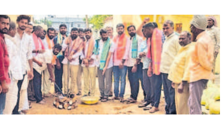
సీసీ రోడ్ల పనులను ప్రారంభిస్తున్న జడ్పీ చైర్మన్ కలక గణేశ్
