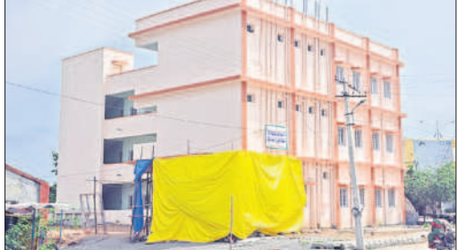
రూ.1.70 కోట్లతో నిర్మాణం పూర్తయి ప్రారంభానికి సిద్ధంగా ఉన్న ఎస్సీ హాస్టల్ భవనం
