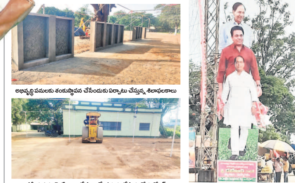
సమీకృత మార్కెట్ నిర్మించే స్థలంలో చదును చేస్తున్న రోడ్డు రోలర్ భారీ కలెక్టర్
