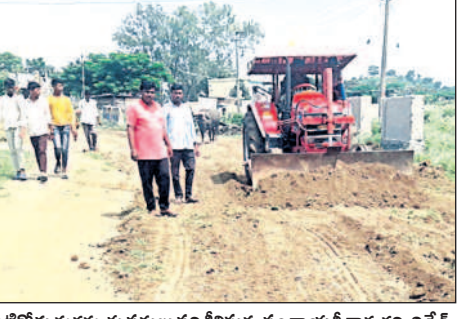
మట్టిరోడ్డు మరమ్మతు పనులు పరిశీలిస్తున్న పంచాయతీ కార్యదర్శి దినేశ్
