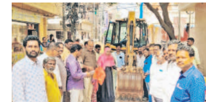
అండర్ గ్రౌండ్ డ్రైనేజీ పనులు ప్రారంభిస్తున్న కార్పొరేటర్ సబీహాబేగం
