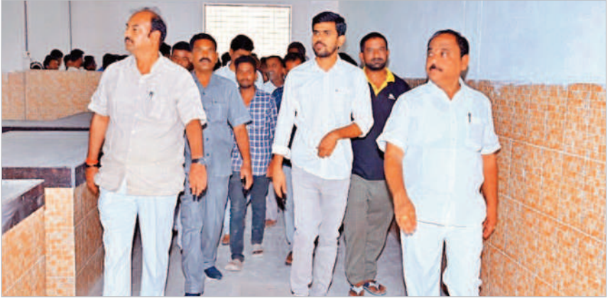
వ్యాపారులతో కలిసి ఇంటిగ్రేటెడ్ మార్కెట్ నిర్మాణ పనులను పరిశీలిస్తున్న ఎమ్మెల్యే బండ్ల కృష్ణమోహన్ రెడ్డి
