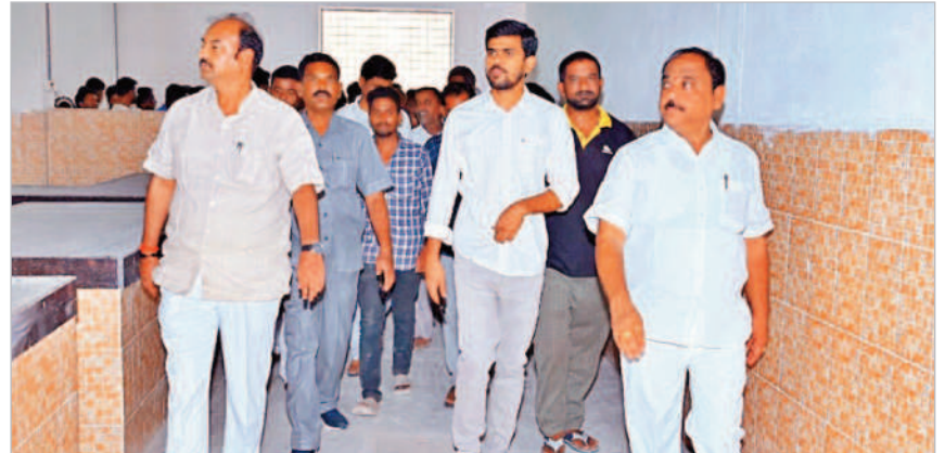
వ్యాపారులతో కలిసి ఇంటిగ్రేటెడ్ మార్కెట్ నిర్మాణ పనులను పరిశీలిస్తున్న ఎమ్మెల్యే బండ కృష్ణమోహన్ రెడ్డి
