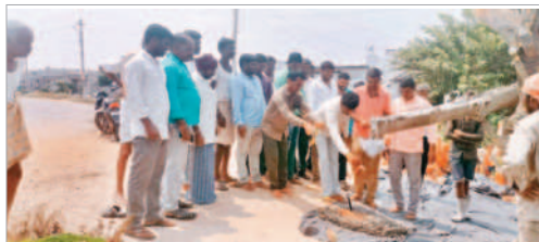
సీసీ రోడ్డు పనులను ప్రారంభిస్తున్న సర్పంచ్ రాజు
