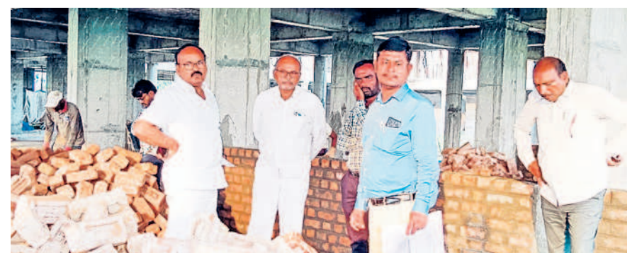
మున్సిపాలిటీ భవన నిర్మాణ పనులను పరిశీలిస్తున్న చైర్మన్ రామ్మోహన్ రెడ్డి, అధికారులు
