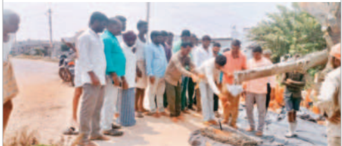
సీసీ రోడ్డు పనులను ప్రారంభిస్తున్న సర్పంచ్ రాజు
