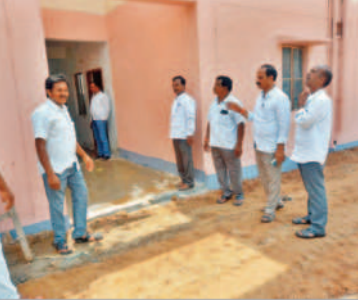
డబుల్ బెడ్రూం ఇండ్లను పరిశీలిస్తున్న బస్వరాజ్ గౌడ్
