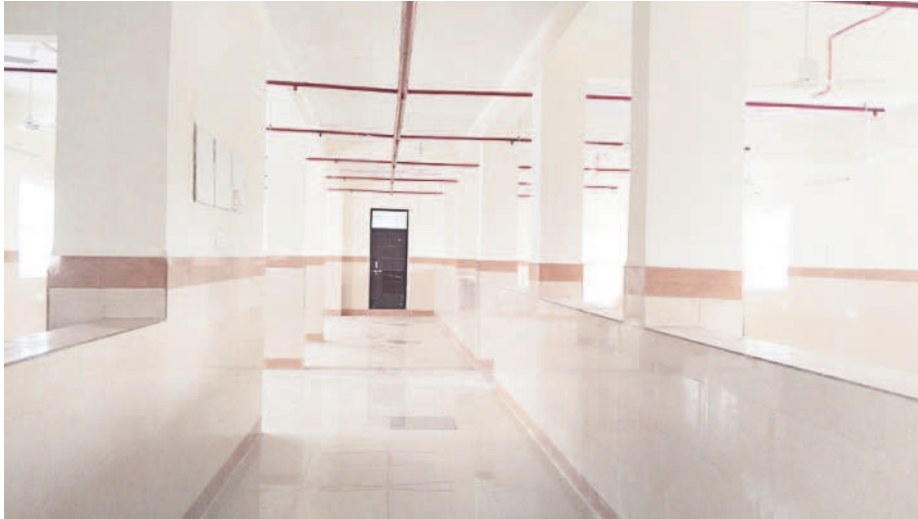
పూర్తయిన అదనపు పడకల భవనం పనులు
