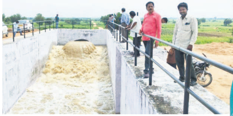
దిలావర్పూర్ పంచాయతీ వద్ద త్రయంబకేశ్వర స్వామి ఎత్తిపోతల నిర్మాణం
