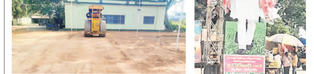
సమీకృత మార్కెట్ నిర్మించే స్థలంలో చదును చేస్తున్న రోడ్డు రోలర్ భారీ కల్నోట్
