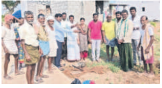
పైపులైన్ పనులను ప్రారంభిస్తున్న సర్పంచ్ యాదయ్య
