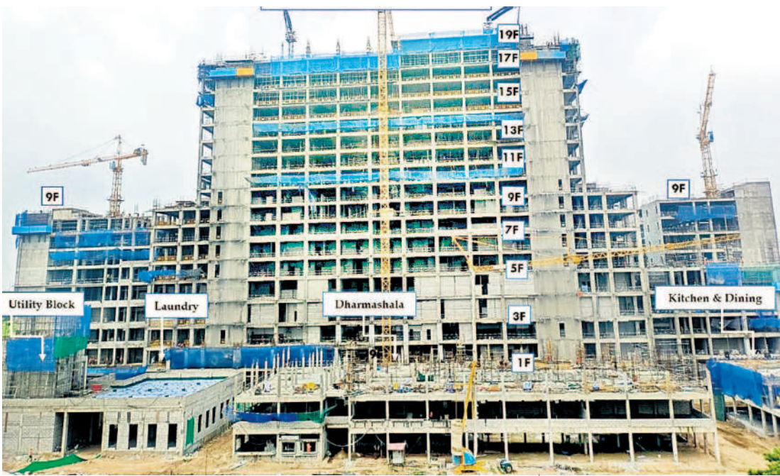
19 అంతస్తులతో నిర్మాణంలో ఉన్న వరంగల్ సూపర్ స్పెషాలిటీ హాస్పిటల్
