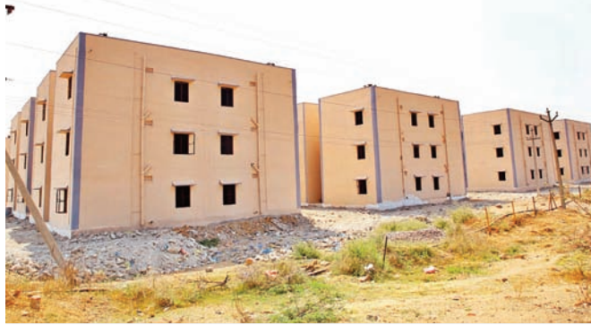
పెట్టేరులో నిర్మించిన డబుల్ బెడ్రూం ఇండ్లు
