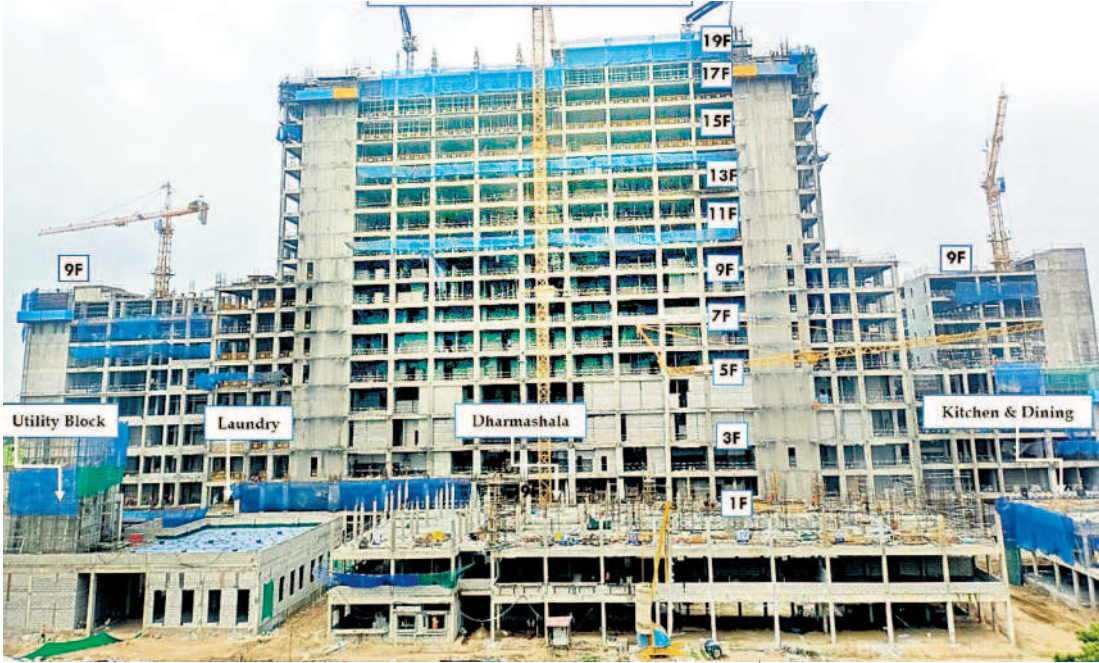
19 అంతస్తులతో నిర్మాణంలో ఉన్న వరంగల్ సూపర్ స్పెషాలిటీ హాస్పిటల్
