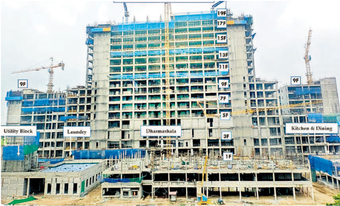
19 అంతస్తులతో నిర్మాణంలో ఉన్న వరంగల్ సూపర్ స్పెషాలిటీ హాస్పిటల్
