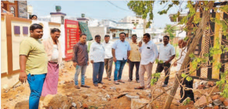
ఆదర్శనగర్లో పనులను పరిశీలిస్తున్న మున్సిపల్ చైర్మన్ నర్సింహాగౌడ్
