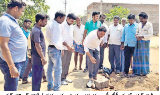
అండర్ గ్రౌండ్ డ్రైనేజీ పనులను ప్రారంభిస్తున్న జడ్పీటీసీ సురేందర్ రెడ్డి
