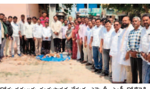
రోడ్డు పనులకు శంకుస్థాపన చేస్తున్న ఎమ్మెల్యే ఎంసీ కోటిరెడ్డి
