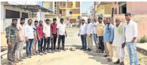
సీసీ రోడ్డు పనులు ప్రారంభిస్తున్న సర్పంచ్ సత్యనారాయణ
