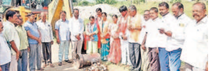
అండర్ గ్రౌండ్ డ్రైనేజీ పనులను ప్రారంభించిన కౌన్సిలర్లు
