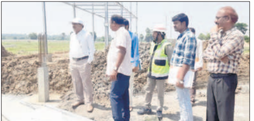
సోలార్ పవర్ ప్లాంట్ పనుల పరిశీలనను శ్రీరాంపూర్ జనరల్ మేనేజర్ సంజీవ్ రెడ్డి
