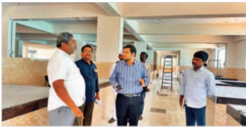
ఇంటిగ్రేటెడ్ మార్కెట్ పనులను పరిశీలిస్తున్న అదనపు కలెక్టర్ అపూర్వ చౌహాన్
