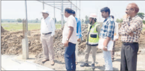
సోలార్ పవర్ ప్లాంట్ పనులను పరిశీలిస్తున్న శ్రీరాంపూర్ జనరల్ మేనేజర్ సంజీవ్ రెడ్డి
