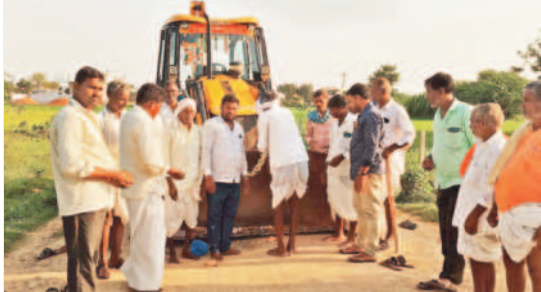
వల్లంపల్లి రోడ్డు నిర్మాణ పనులను ప్రారంభిస్తున్న సర్పంచ్ నర్సమ్మ
