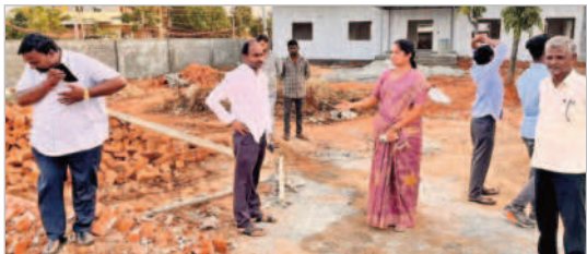
భవన నిర్మాణ పనులు పరిశీలిస్తున్న ఎమ్మెల్యే మర్రి నరసింహా జమున
