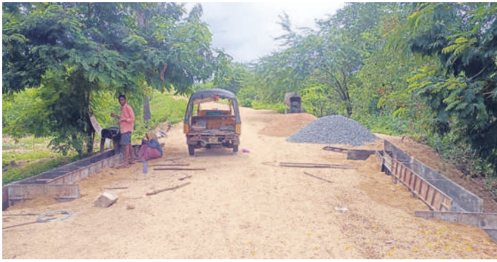
వరద కాల్వపై నిర్మాణాన్ని కల్వర్లు
