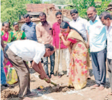
ఇంటి నిర్మాణ పనులను ప్రారంభిస్తున్న సర్పంచ్
