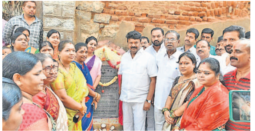
బండిమెట్లో డ్రైనేజీ పైప్లైన్ నిర్మాణ పనులకు శంకుస్థాపన చేస్తున్న మంత్రి తలసాని శ్రీనివాస్ యాదవ్
