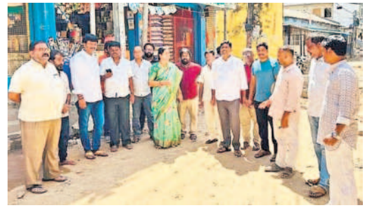
బుర్గుగల్లిలో రోడ్డు పనులను పరిశీలిస్తున్న కార్పొరేటర్ బి.పద్మావెంకటరెడ్డి
