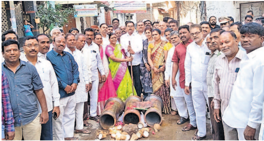
జమాల్బస్టీలో డ్రైనేజీ పైప్లైన్ పనులను ప్రారంభిస్తున్న ఎమ్మెల్యే కాలేరు వెంకటేశ్ తదితరులు
