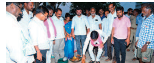
బీటి రోడ్, కల్వర్లు నిర్మాణ పనులకు శంకుస్థాపన చేస్తున్న ఎమ్మెల్యే
