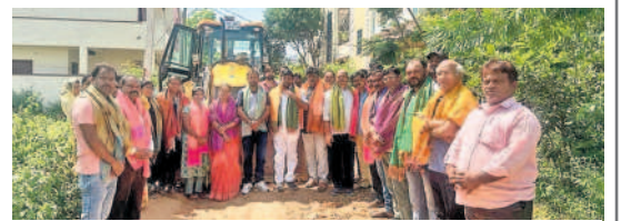
సీసీ రోడ్డు పనులను ప్రారంభిస్తున్న చైర్మన్ ముల్లిపావనీ ముల్లిపావనీ రెడ్డి
