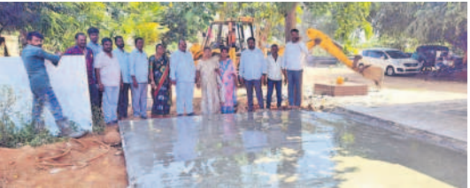
చాదరిగూడలోని దుర్గమ్మ తల్లి ఆలయం వద్ద సీసీ రోడ్డు నిర్మాణ పనులు ప్రారంభిస్తున్న భద్రారెడ్డి తదితరులు
