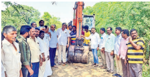
రోడ్డు పనులను ప్రారంభిస్తున్న జడ్పీటీసీ వెంకటరెడ్డి
