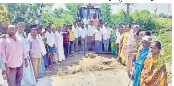
డి.రేపాకలో కల్వర్ట్ పనులను ప్రారంభిస్తున్న మార్కెట్ కమిటీ మాజీ చైర్మన్ మహేంద్రనాథ్
