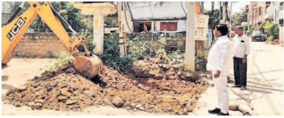
రోడ్డు నిర్మాణ పనులను పరిశీలిస్తున్న మేయర్ మహేందర్ గౌడ్
