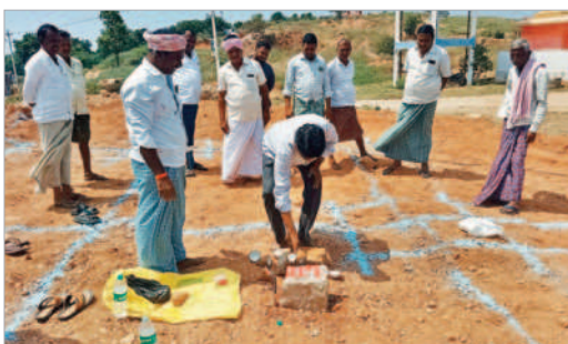
కల్వరాలలో రజక సంఘం భవన నిర్మాణానికి భూమి పూజ నిర్వహిస్తున్న దృశ్యం
