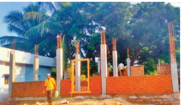
ఉప్పర్పల్లిలో నిర్మాణంలో ఉన్న గ్రామ పంచాయతీ భవనం
