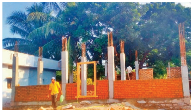
ఉప్పర్పల్లిలో నిర్మాణంలో ఉన్న గ్రామ పంచాయతీ భవనం
