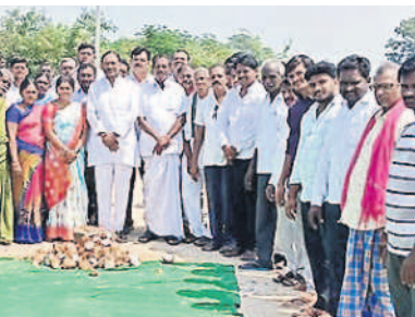
పేరూరు గ్రామంలో సీసీరోడ్డు పనులకు శంకుస్థాపన చేస్తున్న ఎమ్మెల్యే ఎంపీపీ కోటిరెడ్డి
