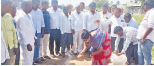
చేర్యాలలో సీసీ రోడ్డు నిర్మాణ పనులను ప్రారంభిస్తున్న మున్సిపల్ చైర్పర్సన్ స్వరూపారాణి
